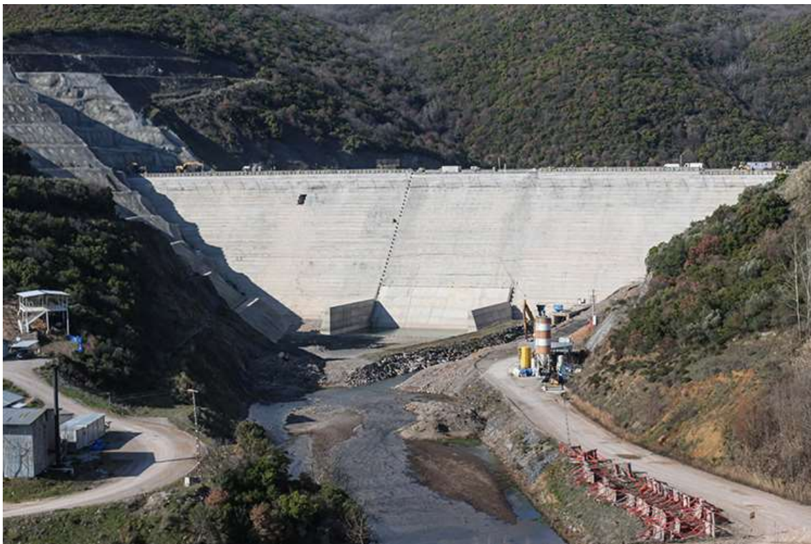
Слика 8. Поглед кон низводната косина на браната Ѓолеџик во изградба.
