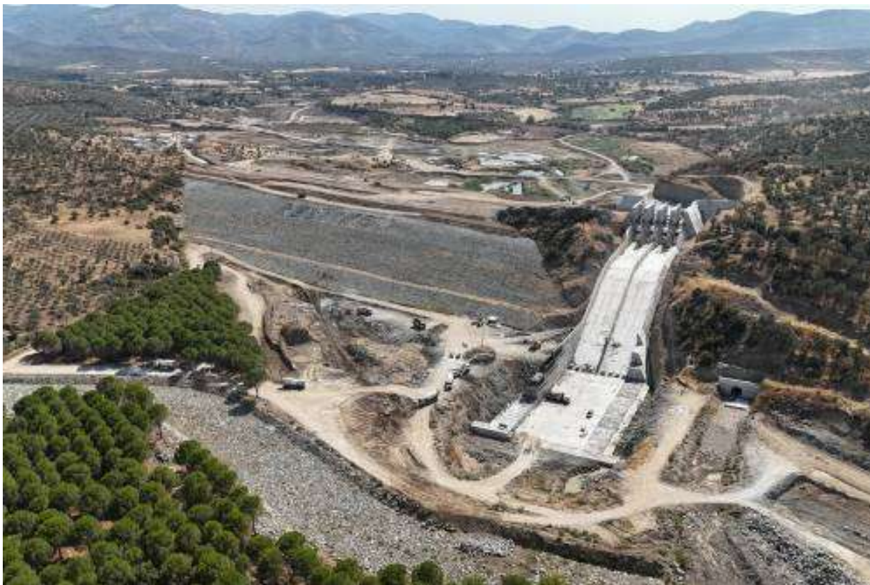
Слика 12. Поглед кон низводната косина и преливникот на брана Reşitköy.
