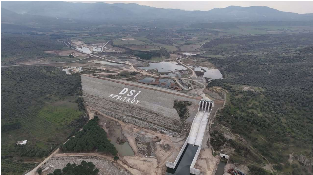
Слика 14. Поглед кон низводната косина и преливникот на брана Reşitköy.
