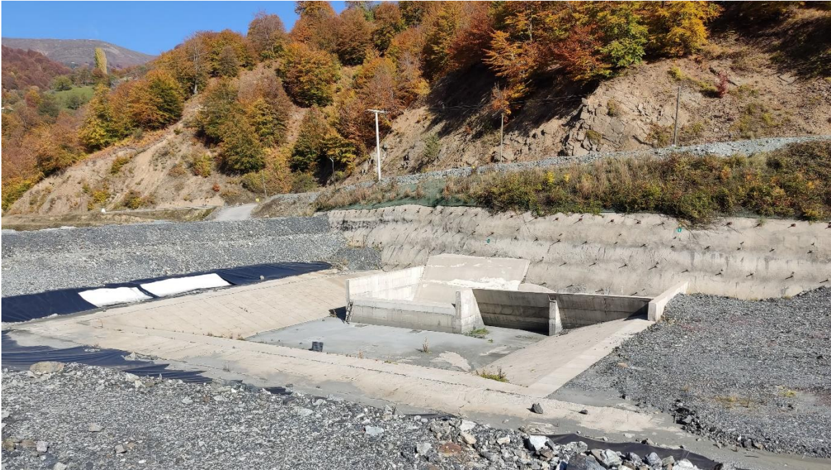
Собирен канал на преливник на таложно езеро Саса 3-2, стручна посета на хидројаловишта на рудникот Саса, М. Каменица, 22.10.2022
